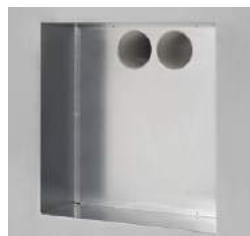
Unterputzgehäuse montiert
